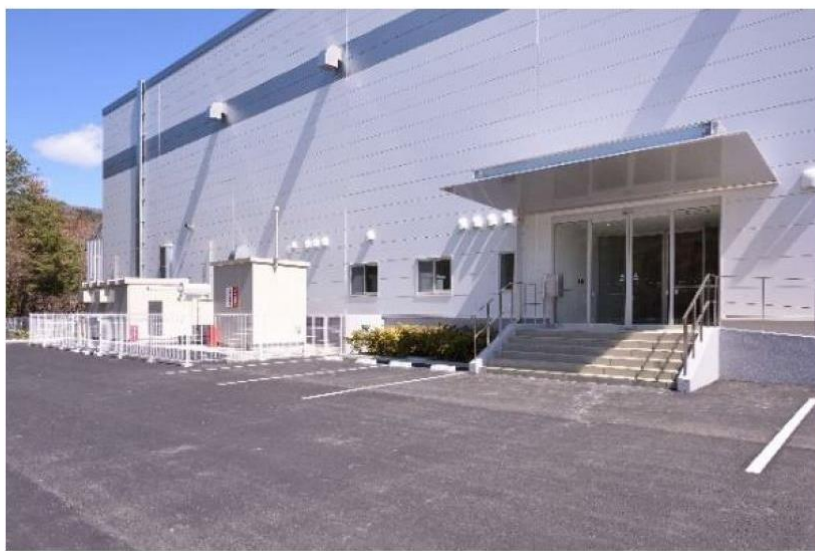
エントランス外側
