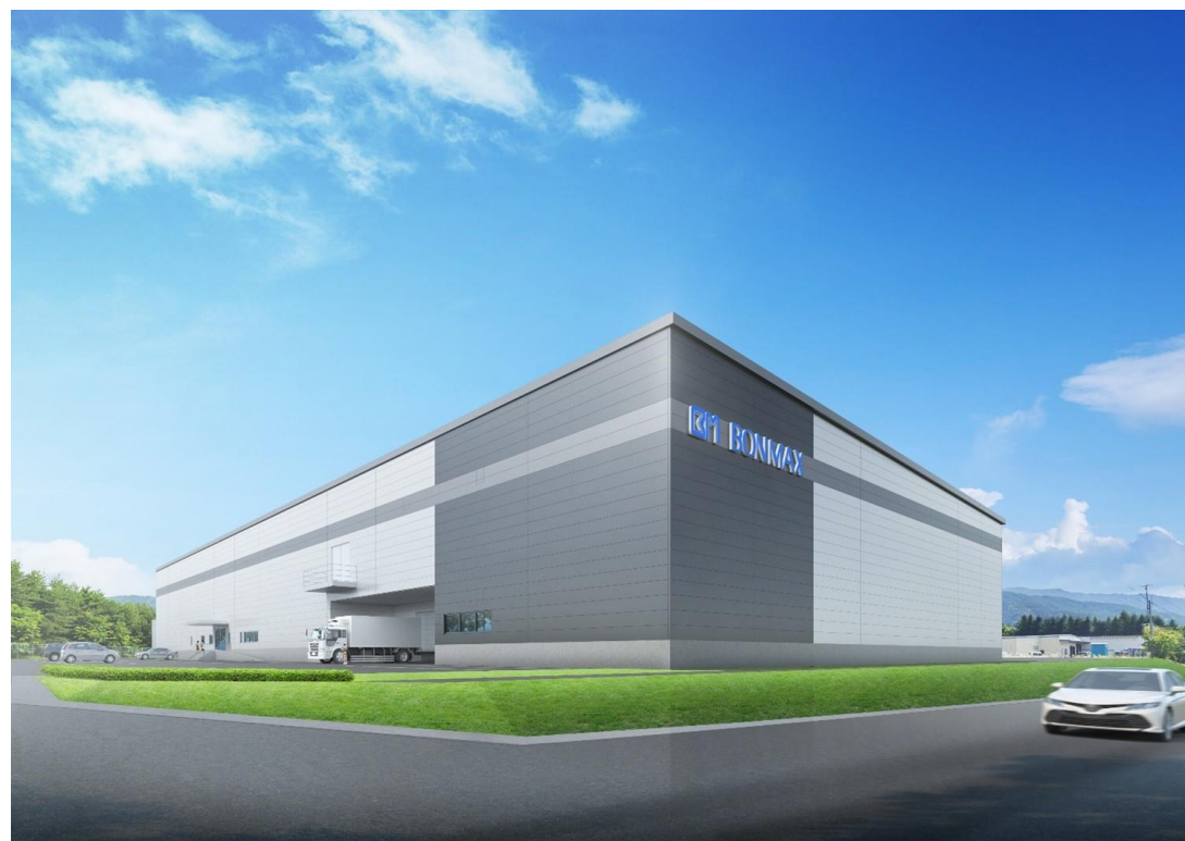
鉄骨2階建てで、延べ床面積は約1万1000平方メートル
